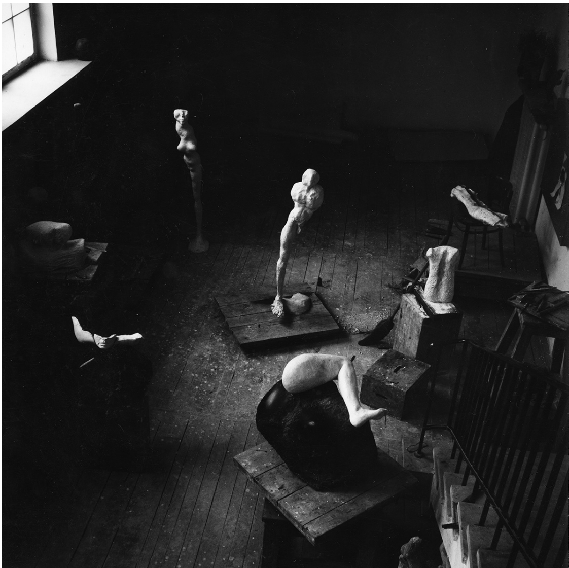
Vue de l'atelier d'Alina Szapocznikow, rue Brzozowa, Varsovie, Pologne Photographie de Marek Holzman 1965
